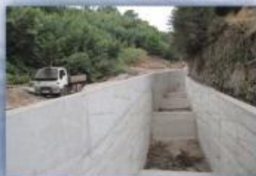
Canalização de uma ribeira - Madeira in http://www.abocanamento.com/interiores.php?ID=302/331/
